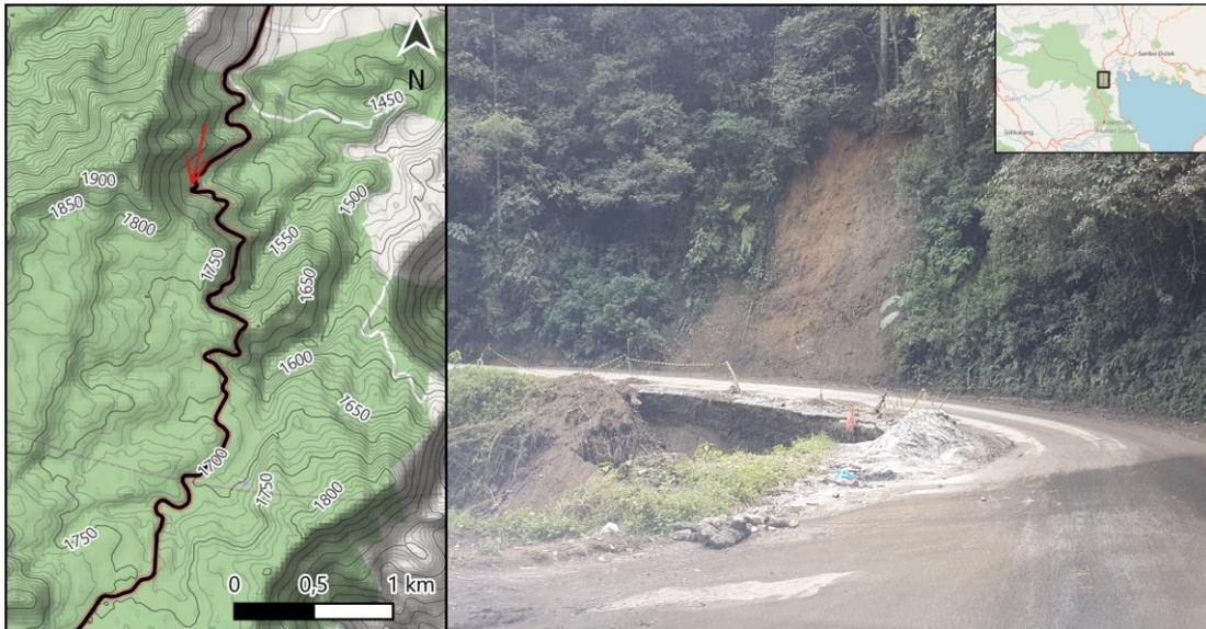
Gambar 20. Bagian dengan tikungan tajam di selatan Merek. Jalan dalam kondisi buruk, dan beberapa tanah longsor baru-baru ini diamati.
