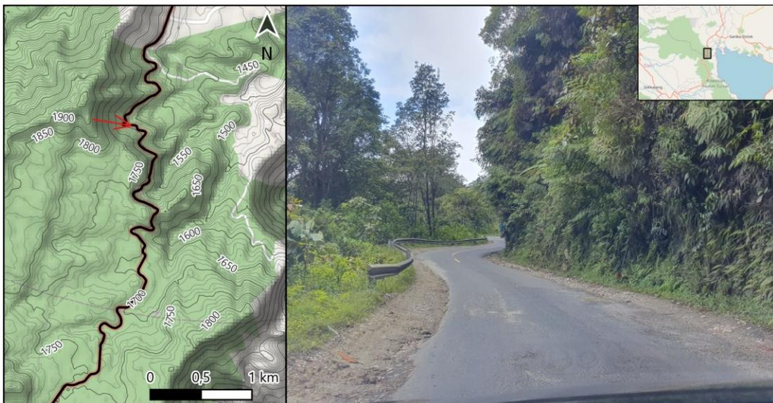
Gambar 21. Bagian dengan tikungan tajam di selatan Merek. Jalan ini dalam kondisi yang lebih buruk daripada daerah lainnya dan memiliki kemiringan curam di satu sisi jalan.
